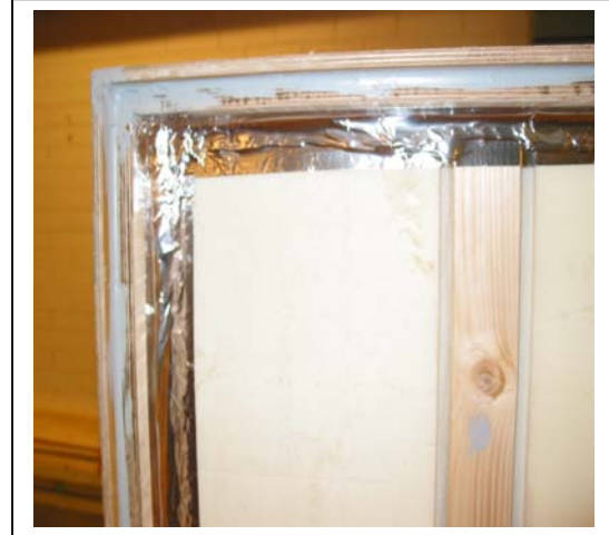
Kuva 2. Lämmöneristeen ja kehon väli tiivistettiin kuvassa näkyvällä alumiiniteipillä ja sen alla olevalla polyuretaanivaahdotuksella.
